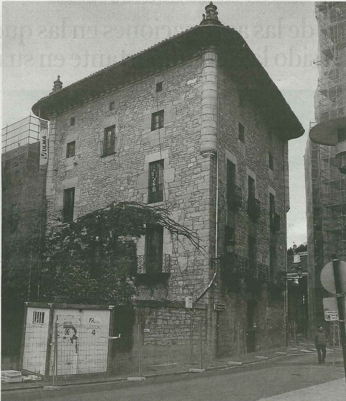
La obra en la Torre Olaso, un inmueble sobrio y elegante, respeta al máximo sus elementos originales. FOTO: A.D.
